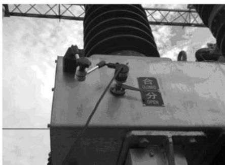
35KVSF6 开关传感器安装
